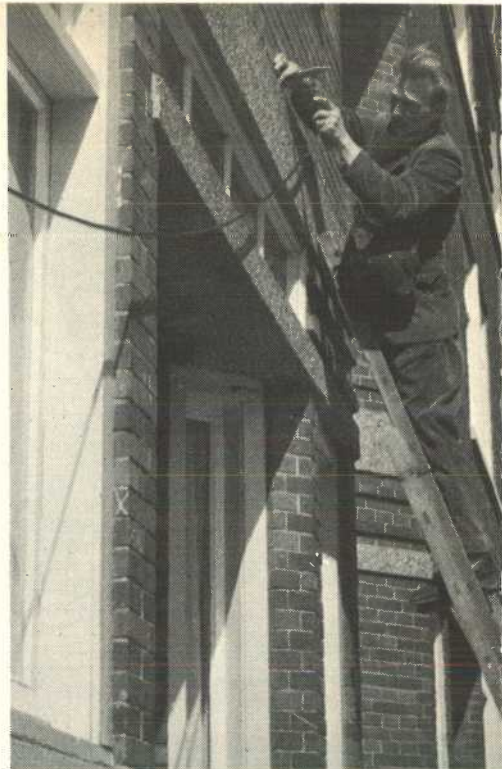
„Zo zal bij de „oude” telefoonbekabeling een extra hoogfrequentkabel van EMI worden aangelegd als „draad-ether”.
